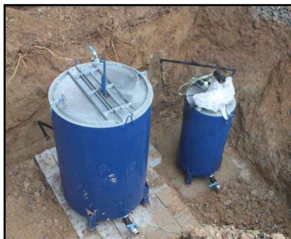
Figura 02: Instalação do Protótipo
