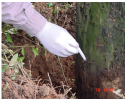
Figura 1. Retratamento de postes: a) aplicação de bandagem fixa (preservativo a base de boro e flúor) b) aplicação de bastonete (preservativo a base de boro). Fonte: Vidor, 2003.
