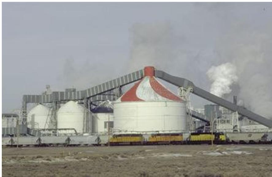
O carbonato de sódio é classificado como denso ou de alta pureza, e enviado para silos de armazenamento apropriados.
